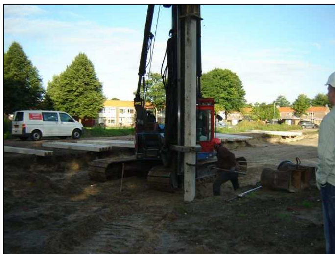
De eerste paal wordt geslagen
