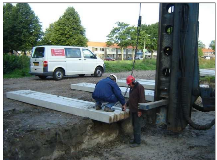
De heipalen worden in de heimachine getakeld
