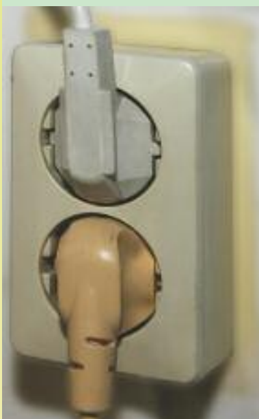
Dubbele wandcontactdoos met randaarde
