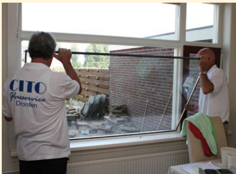
Doordat er een cd-box in de vensterbank stond, weerkaatste het licht van de cd naar het glas. Hierdoor werd het glas warm en ontstond er een thermische breuk.
